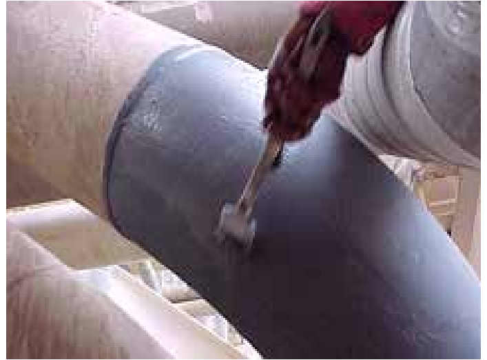
使用贝尔佐纳 (Belzona) 5841 为管道提供腐蚀防护
