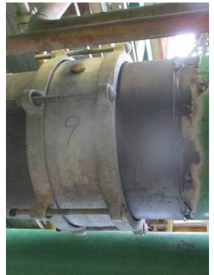
重新安装修复后的联轴器
